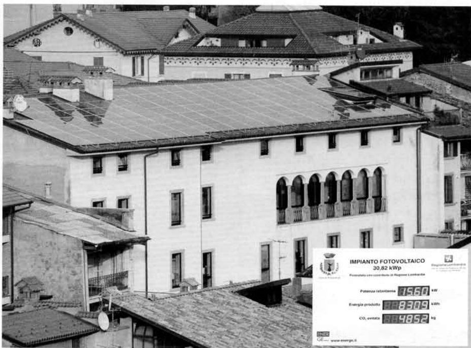
Un pannello rileva il risparmio energetico ottenuto.
